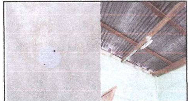
Foto 10: Sustitución de focos ahorradores y plafoneras
