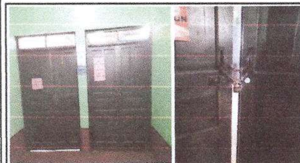
Foto 3: Sustrucción de puertas de madera por metal
