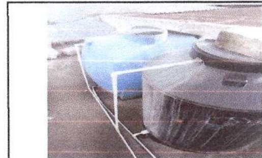
Foto 12: Sustitución de depósito de agua de 1100 litros
