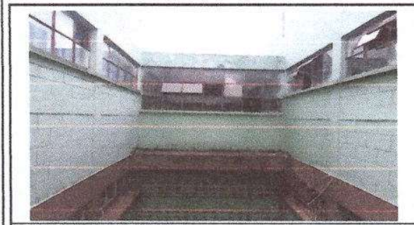
Foto 5: Sustrucción de vidrios
