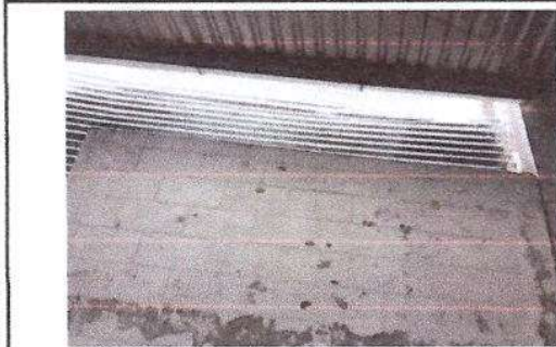
Foto 9: Muros perimetrales, reparación de tubos hg
