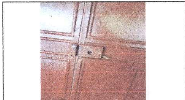
Foto 4: Sustrucción de chapas
