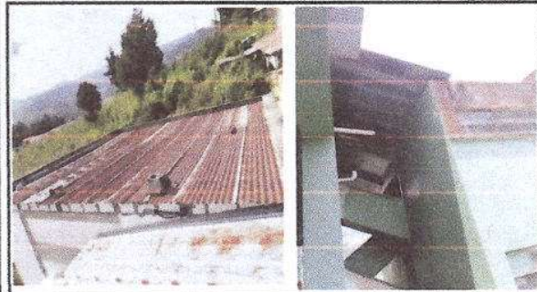
Foto1: Sustrucción de lámina en aulas y gradas
