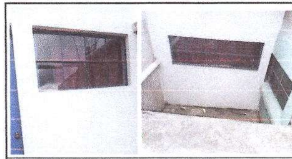
Foto 6: Colocacion de balcones en área de laboratorio
